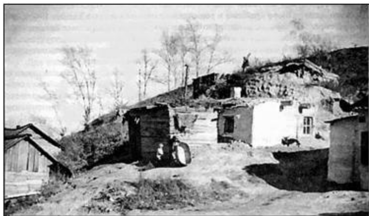
Землянки на окраинах тылового Барнаула были обычным явлением. На снимке землянки улицы Ивановский лог (ныне ул. С.И.Гуляева). Фото Л.И.Борисенко, из фондов АГКМ, 1948 г.
