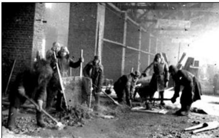
Строительные работы не прекращались и в сорокаградусные морозы. Фото 1944 г., зима.
