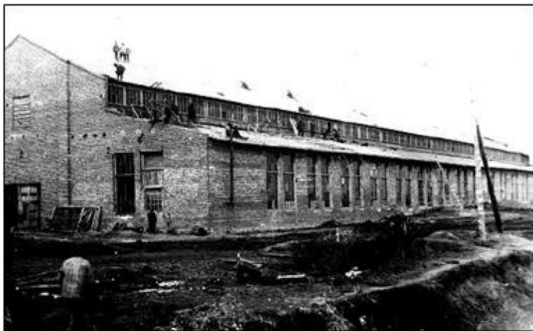
Заканчивается строительство блока второго и третьего цехов Барнаульского котельного завода. Фото 1944 г.
