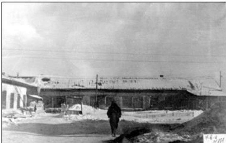
Помещения технических ремонтно-строительных мастерских, в которых начал работу образованный в 1942 г. завод № 839. Завод поставлял для фронтовой авиации высотно-кислородную аппаратуру. В 1945 г. переименован в Барнаулский аппаратурно-механический завод. Фото 1940-х гг. из фондов музея гимназии № 80
