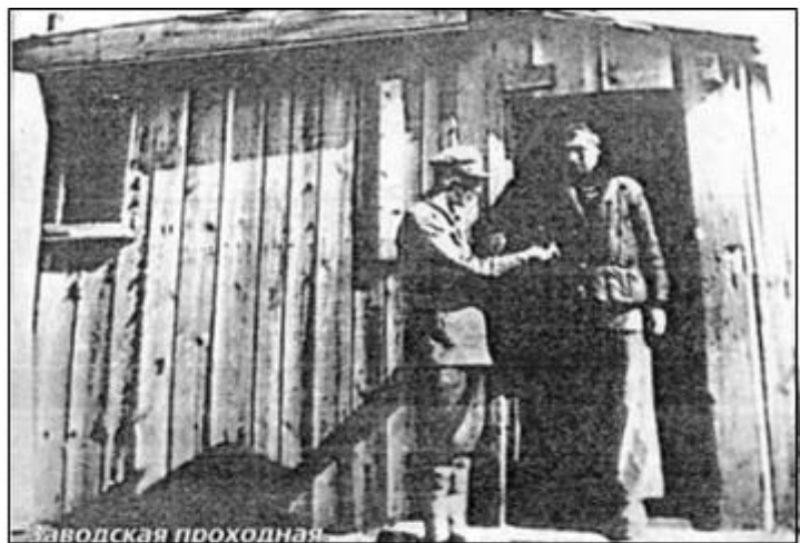
Заводская проходная строящегося завода № 77 («Трансмаш») Фото 1942 г.
