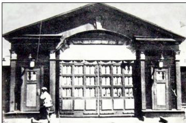
Строительство завода изменило и вид его проходной. Проходная завода № 77 в 1944 г.
