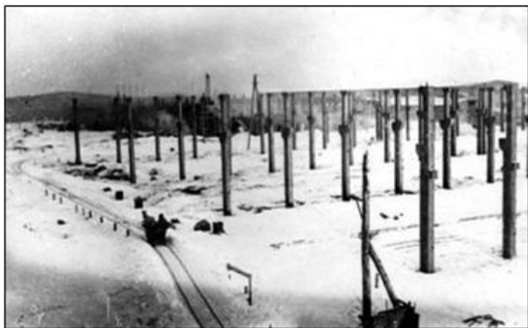
Строительство Барнаульского котельного завода. Остовы будущих цехов. Мощные колонны устанавливались вручную при помощи блоков Фото 1943 г.
