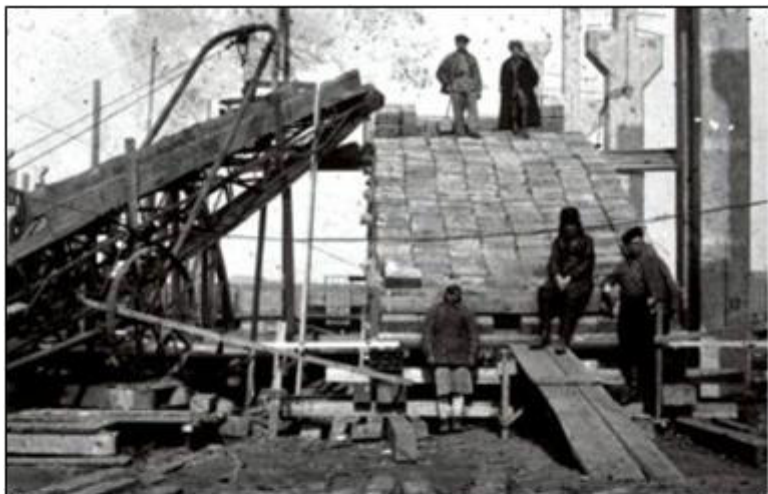
На строительстве Барнаульского котельного завода. Фото 1943 г.
