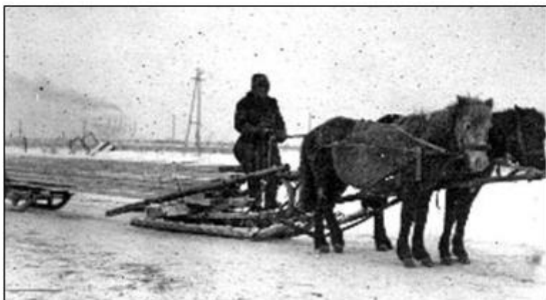
Доставка пиломатериалов на объекты строительства. Основная тяговая сила - лошадь. Фото 1940-х годов...
